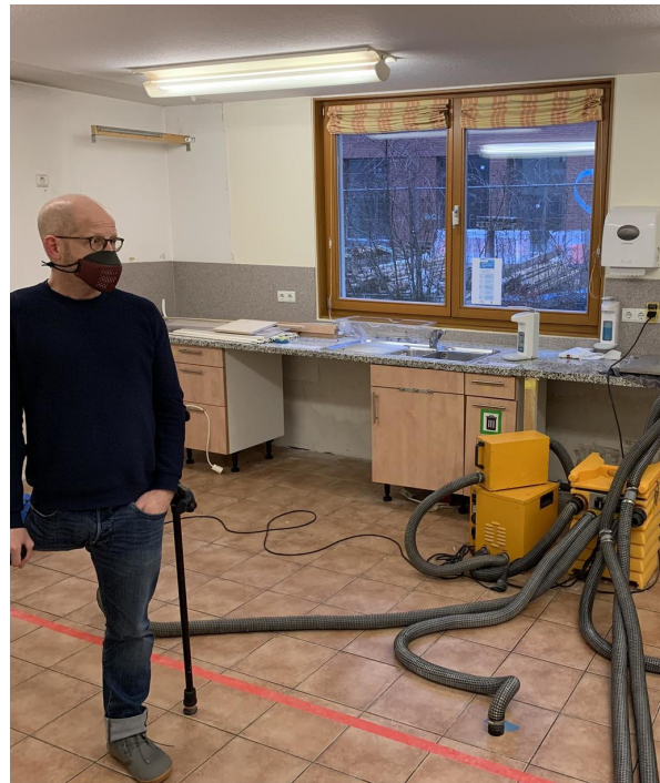
Simon Schlattmann in einem der Gemeinschaftsräume, die vom Wasserschaden betroffen sind. Voraussichtlich bis Februar werden die Trockner in Betrieb sein. (kal)
